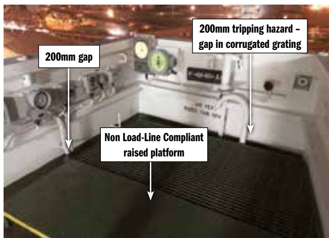
Tripping hazards sa bridge wing – kinakailangan na may limitadong taas na 1000mm
