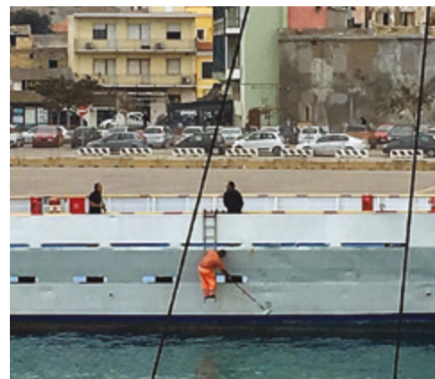
Pagpipintura sa gilid – kawalan ng safety precautions
