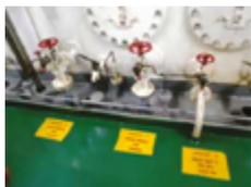
对机舱速闭阀进行标记，有助于在进行测试和操作期间识别阀门。
