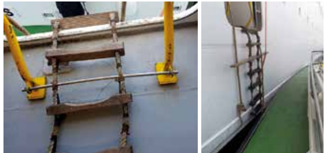
Illegal at lubhang mapanganib na pamamaraan sa pag-rig ng pilot ladder
